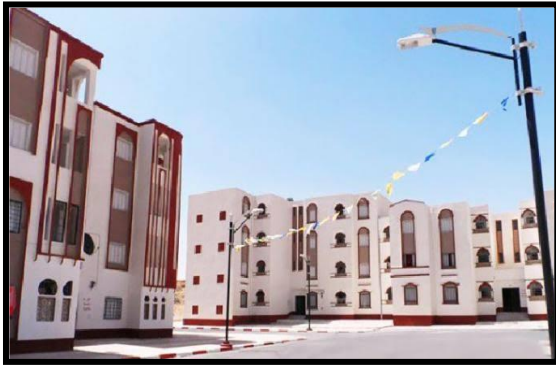
PHOTOI III. 6: Habitat collectif à Touggourt
