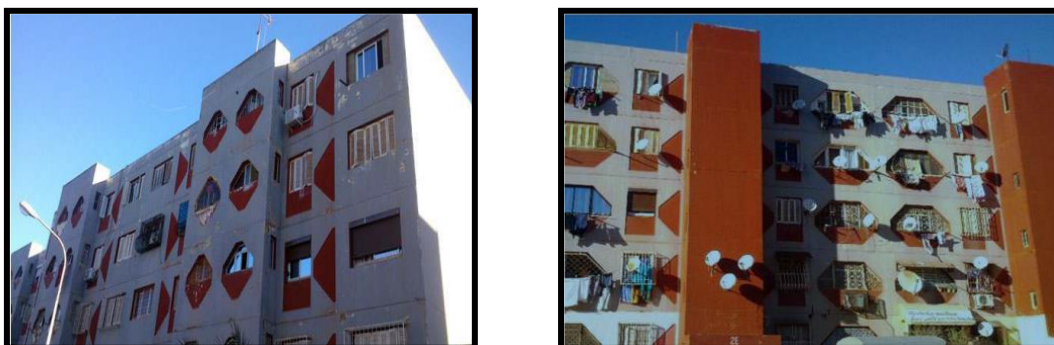
PHOTO III. 4: Les changements au niveau des façades
