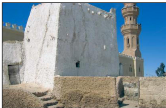
Figure 5 :Siwa : tombeau du saint Sîdî Suleyman (architecture de terre blanchie à la chaux)
