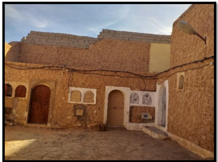
Figure 10 : Façade d'une maison du ksar Tinemmirine
