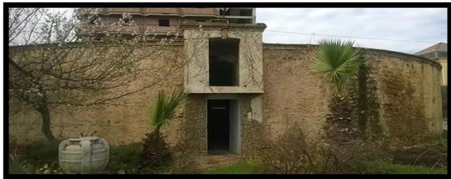
On remarque que la structure verticale du Musée de CHLEF est construite par des moyens et grands moellons, et dans les ouvertures (porte et fenêtre) des petits moellons.
