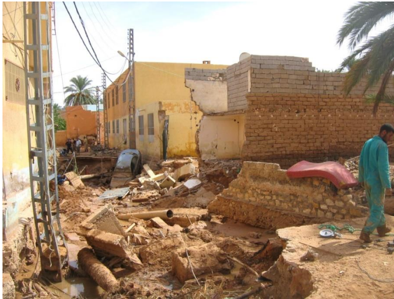
Effondrement des infrastructures : voirie, réseaux..... etc Source OPVM
