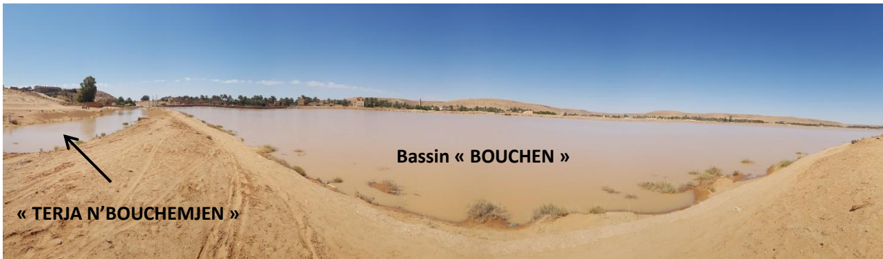
Vue sur le système de gestion des eaux dans la partie Est de la palmeraie de Ghardaïa
