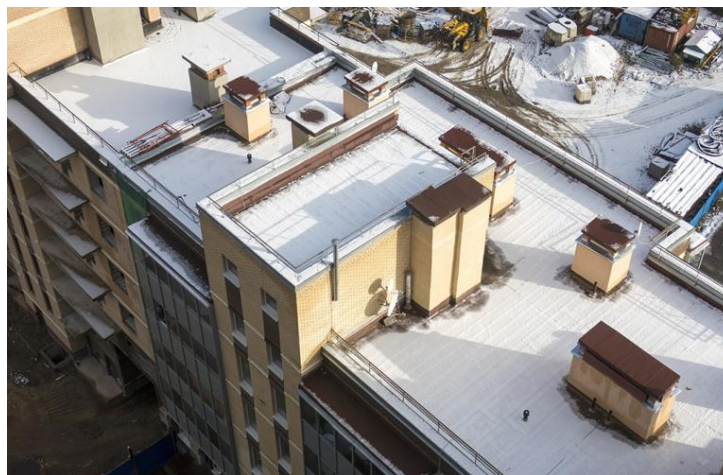
Figure III.1 : Effet de Neige sur Toiture.[12]
