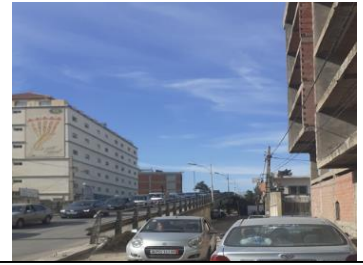
Figure 31 : le tronçon de la rue représente le conflit Source : Google
