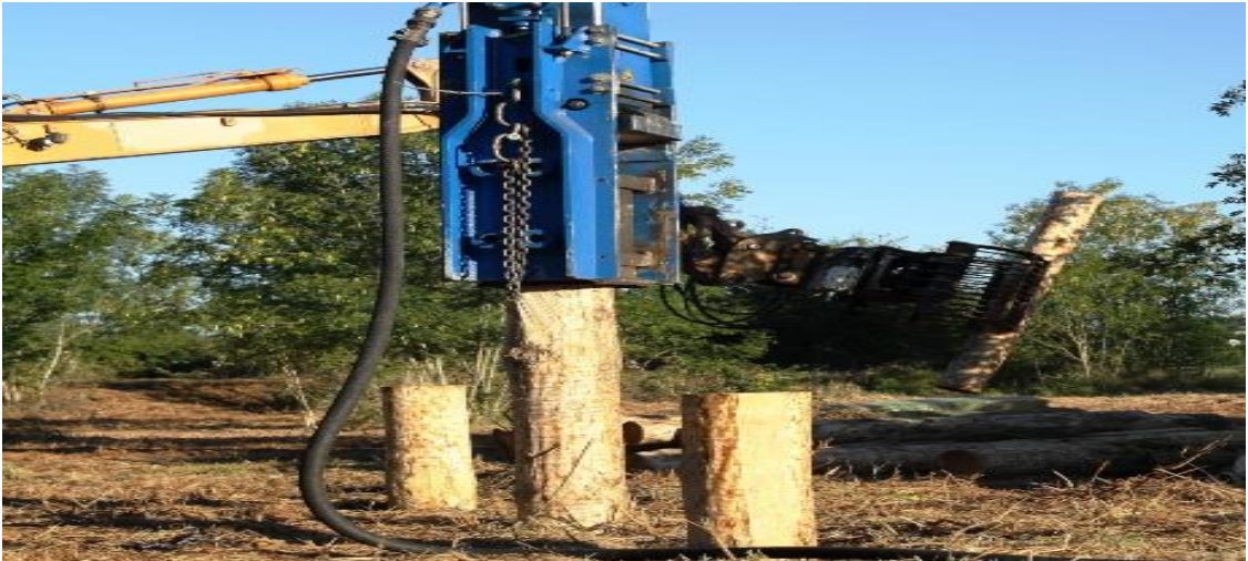
Figure I.19: Pieux en bois
