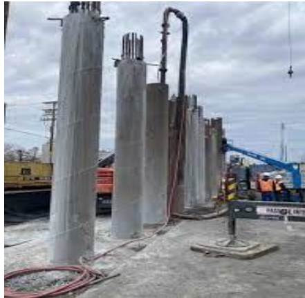
Figure I.21 : Pieux en béton armé
