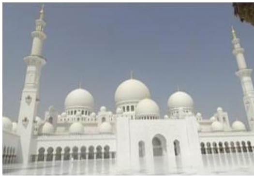
Fig. n°69 : Vue sur les dômes principaux Source : https://www.girltravelsplanet.com/home/2017/11/25/the-sheikh-zayed-grand-mosque-in-pictures
