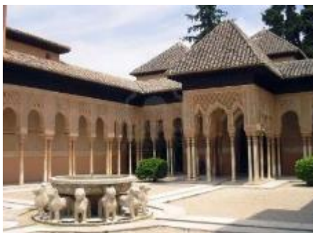
Fig. n°56 Mosquée d'Alhambra à Grenade, l'utilisation de la tuile pour la couverture.
