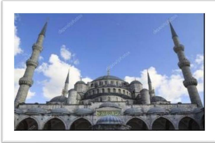
Fig. n°86 : La façade de la mosquée bleue
