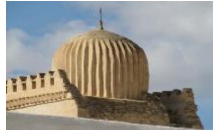
Fig. n°45 : La coupole de la mosquée du Kairouan Source : http://fr.123rf.com
