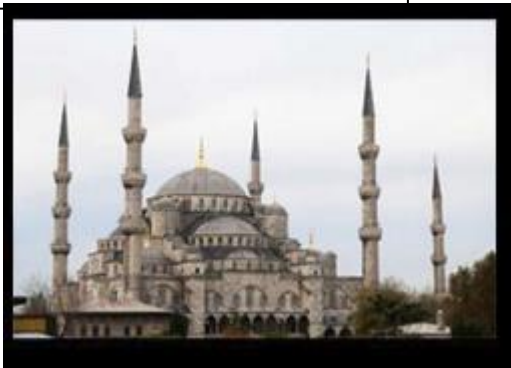
Fig. n°85 : le dôme de la mosquée
