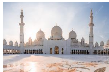
Fig. n°68 : la cour centrale de la mosquée
