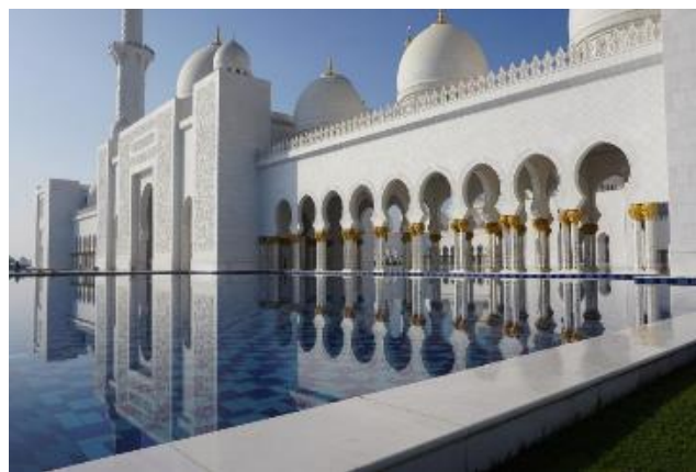
Fig. n°74 : Les bassins bordant les arcades
