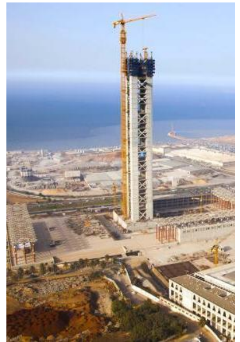
Fig. n°142 : Minaret en cours de construction
