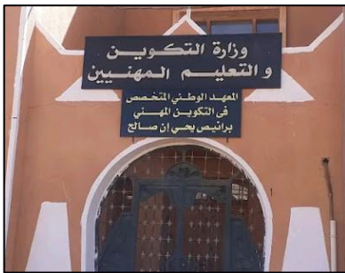
Figure 48 : Institut de formation. Source : L'auteur
