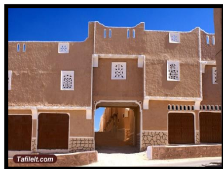
Figure 26 : Façade à texture rugueuse
