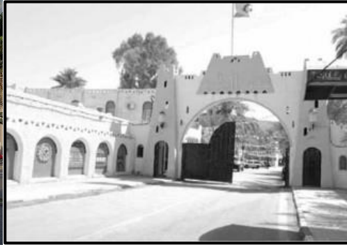
Figure63 :entrée principale de la wilaya de Ghardaïa
