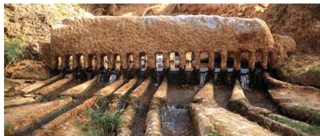
Figure 11 système de foggara Timimoune Algérie source : En vie d'oasis –03-2009
