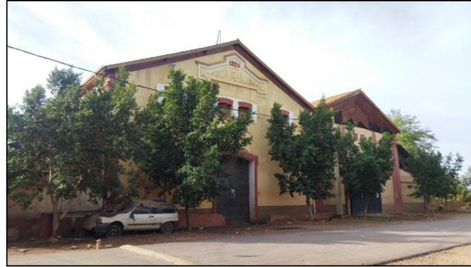
Figure 94: la façade principale de la cave coopérative
