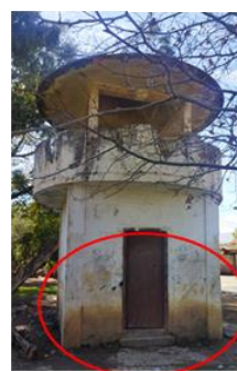
Figure 156: l'état de la sulfaterie
