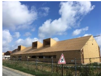
Figure 28: L'ossature extérieure du nouveau bloc de service
