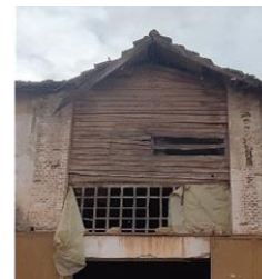
Figure 108: un poteau en brique pleine
