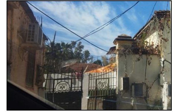
Figure 81: l'entrée 02 du noyau central Source : Par l'auteur
