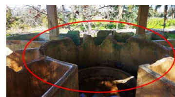
Figure 151: l'état des bassins du sulfaterie
