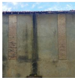
Figure 109: les poteaux en brique pleine
