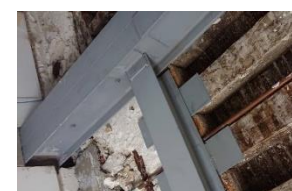
Figure 57: Les planchers en solives métalliques
