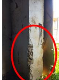
Figure 127: les murs au niveaux des portes
