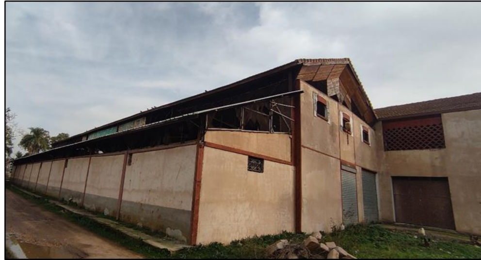
Figure 96: le hangar avec annexe de la cave coopérative
