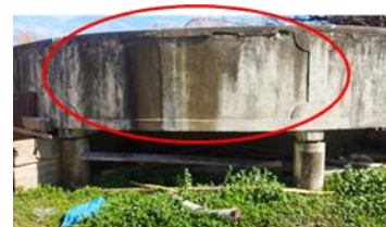
Figure 150: l'état du réservoir
