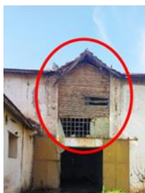
Figure 123: les murs au niveaux des portes
