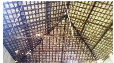
Figure 113: le nœud de jonction des 12 éléments
