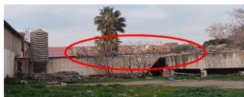
Figure 138: la toiture de la grange 02
