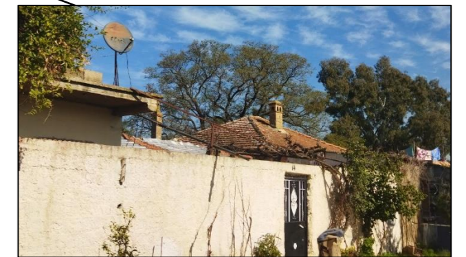
Figure 86: maison des ouvriers Source : Par l'auteur
