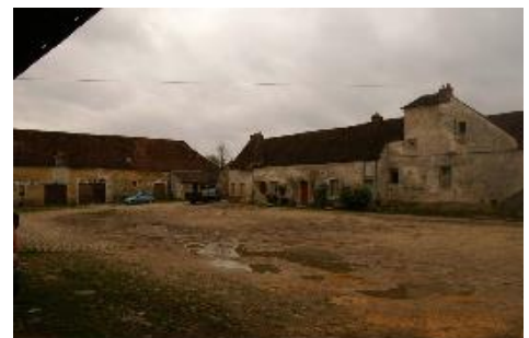
Figure 14: l'état de la ferme avant la reconversion
