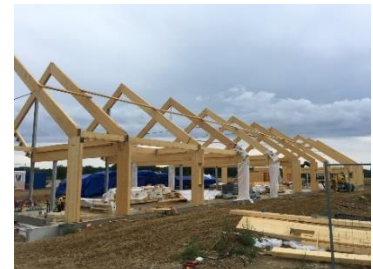
Figure 29: structure du nouveau bloc de service
