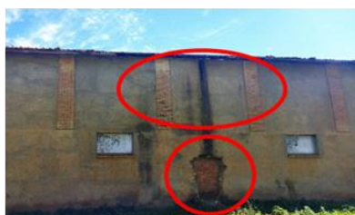
Figure 129: le trou dans le mur ouest
