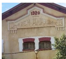
Figure 104: les fenêtres en bois et verrière
