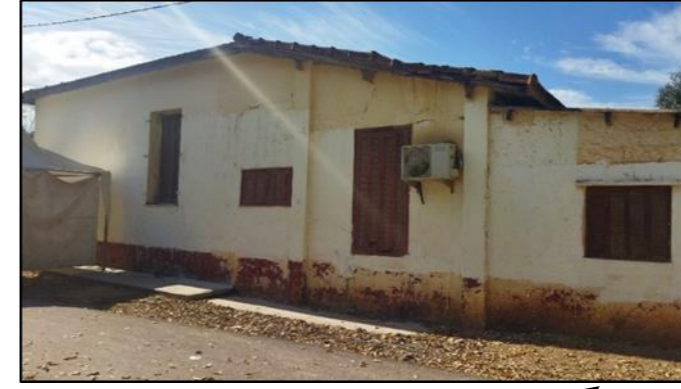
Figure 82: maison de maitre Source : Par l'auteur
