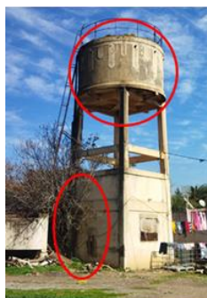
Figure 155: l'état du réservoir
