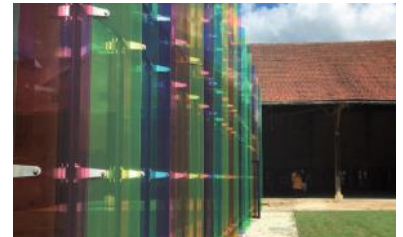
Figure 20: le nouveau traitement de façade adopté Source : https://bn-architectures.com/maison-des-services-du-val-briard-pole-petite-enfance/
