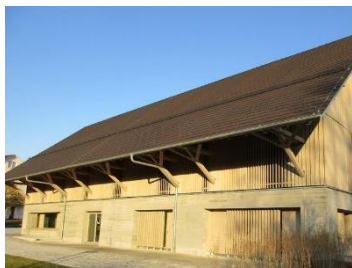
Figure 45: la tuile utilisée pour la toiture de la bibliothèque
