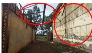
Figure 143: l'état de l'annexe 01
