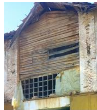
Figure 183 : les lames de bois des entrées d'étable
