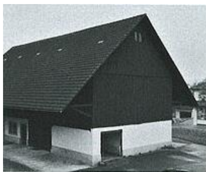
Figure 41: : photo de l'ancienne grange de Kressbronn
