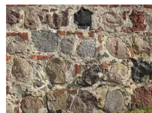
Figure 56: Les murs en maçonnerie mixte
