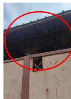
Figure 148: les ouvertures en treilles rouillée
