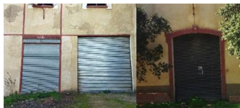
Figure 107: la menuiserie en métal et aluminium
