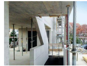
Figure 44: le béton brut utilisé dans la bibliothèque
