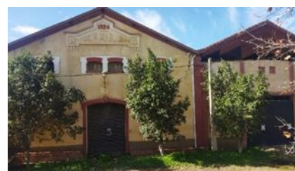
Figure 119: la façade de la cave coopérative
