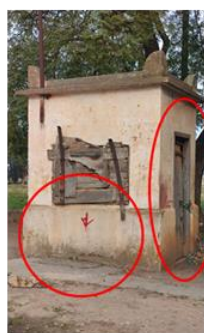
Figure 153: l'état du Pont bascule
