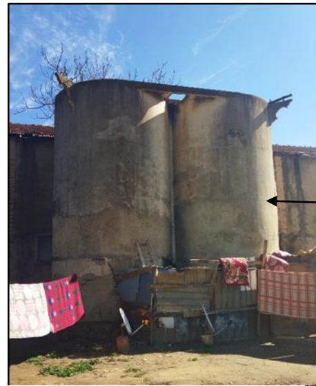
Figure 92: silos en béton Source : Par l'auteur
