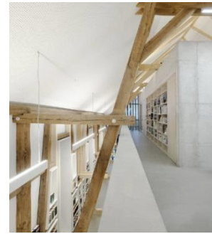
Figure 47: le charpente en bois restauré
