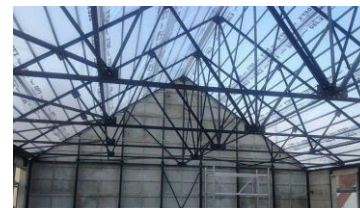
Figure 180 : type de ferme proposé pour les 4 directions de
