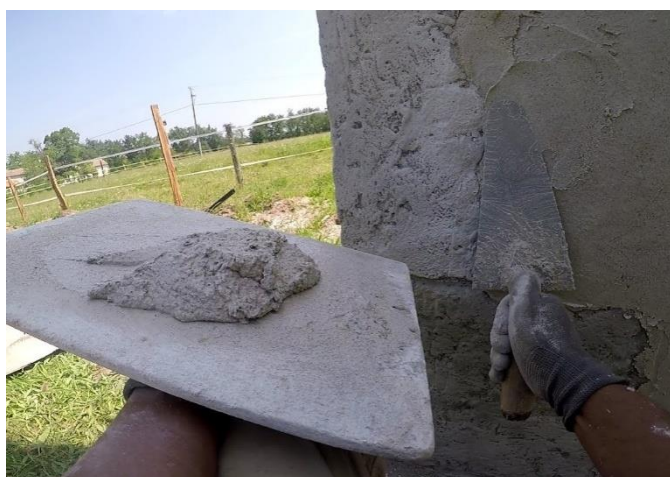
Figure 1. 11 : Enduit traditionnel.
