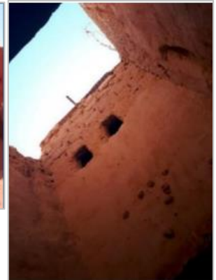
FIGURE ILXXXVI.51: Façade au Ksar de Timimoune Source :
