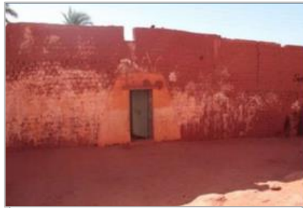
FIGURE ILXXXVII.50: Façade au Ksar de Timimoune Source : Etudiants
