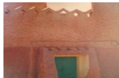
Figure ILXXXIV.49: Façade au Ksar de Timimoune Source : Etudiants
