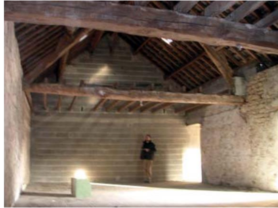
Vue sur les charpentes avant les travaux.
