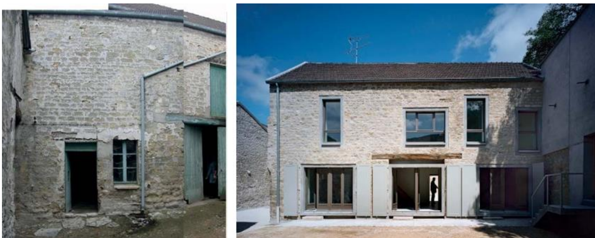
Figure 22 : L'état initial / L'état final
