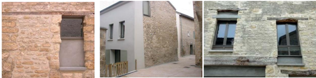
Trace d'une fenêtre rebouchée et d'un percement.
