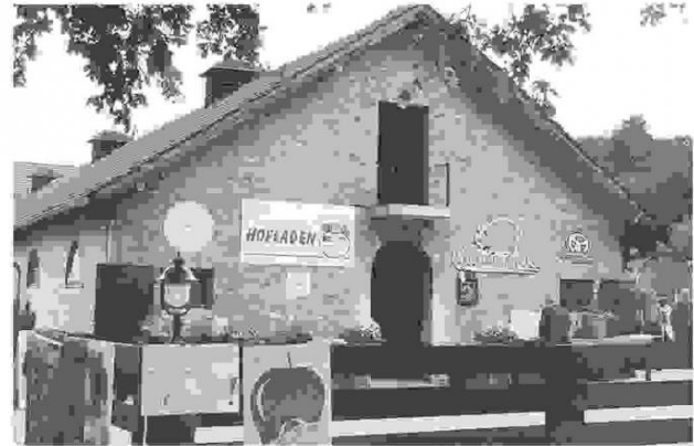
Figure 11 : Abandon et reconversion des anciens bâtiments agricoles, Berlin
