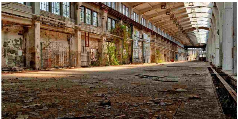
Figure 5 : Une friche industrielle, Source : https://entreprises.nexity.fr/regards-croises/environnement/friches-industrielles-fabrique-de-la-ville
