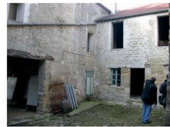
Vue sur une cour intérieure avant les travaux.
