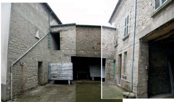
Les bâtiments A, C, B avant les travaux
