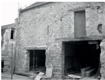
Vue sur l'un des corps de bâtiments (C) en pierre, marqué par peu d'ouvertures et une forte matérialité de sa façade et de sa structure.
