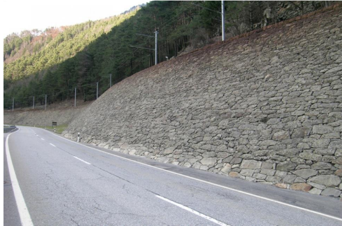
Figure I.8. Mur en maçonnerie de pierres sèches
