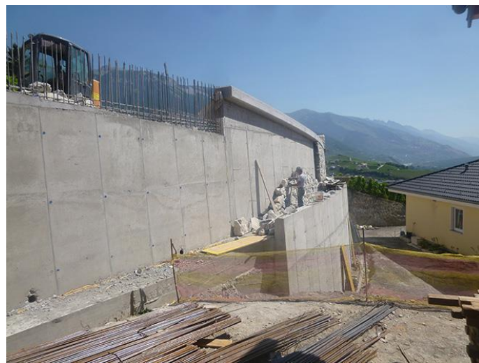
Figure I.9. Mur poids en béton
