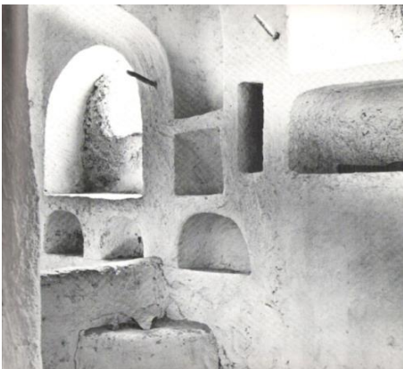
Figure 53:utilisation du plâtre dans les maisons
