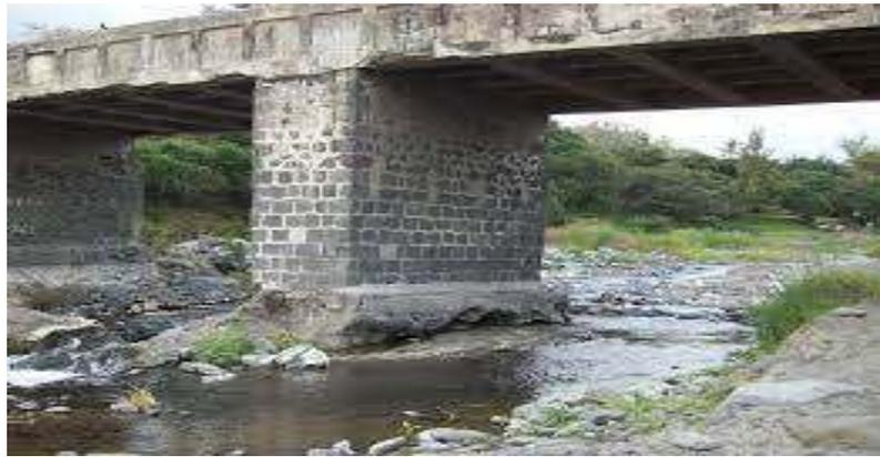
Figure I. 24: Un exemple d'affouillement autour des piles de pont.
