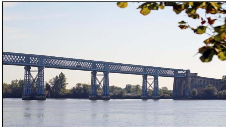
Figure I. 8: Pont routier avec des piles métalliques.
