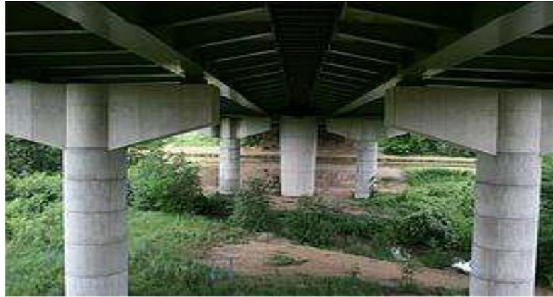
Figure I. 15: Pile avec chevêtre.
