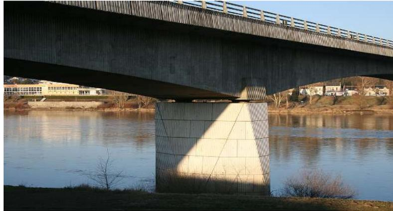
Figure I. 9: Pile en béton.
