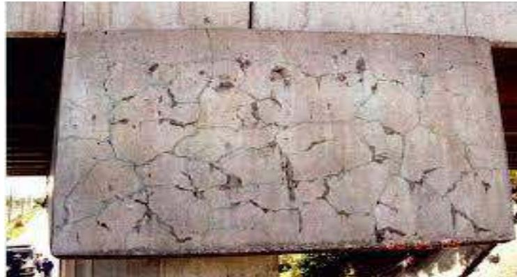
Figure I. 30: L'attaque des sulfates sur la pile d'un pont [4]
