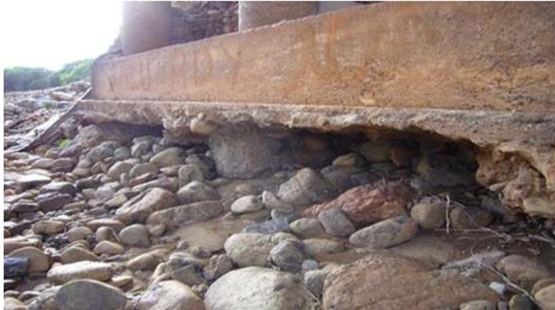
Figure I. 27: Phénomène d'affouillement sur fondation profonde. [4]
