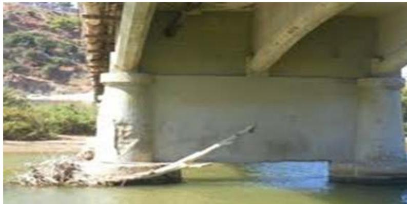
Figure I. 29: Désordre à la base des piles du pont sur Oued Allala (Ténès). [3]
