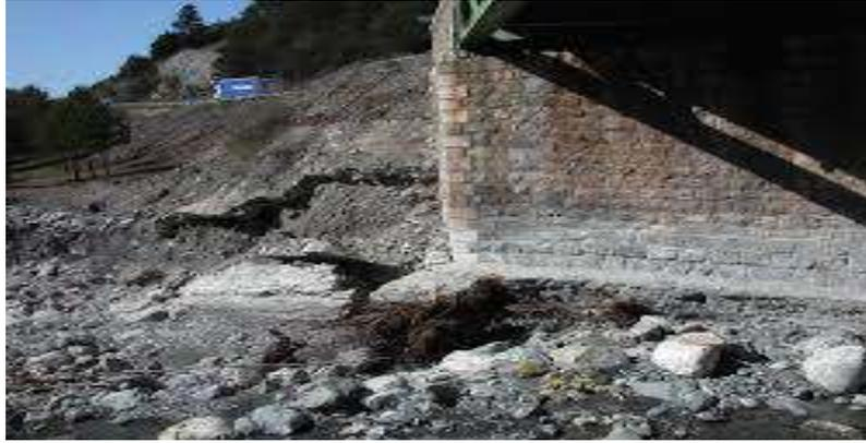
Figure I. 25: Un exemple d'affouillement autour d'un culé de pont. [3]
