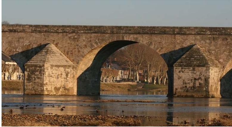
Figure I. 7: Pile en maçonnerie protégées.
