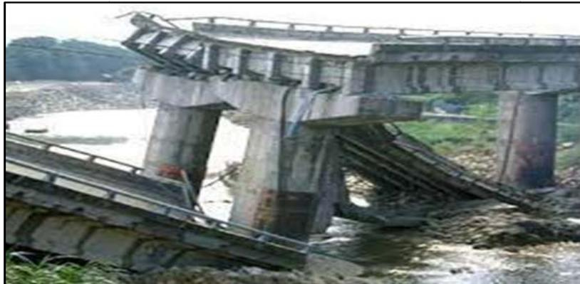
Figure I. 21: Effondrement du pont a cause du cours d'eau [4]
