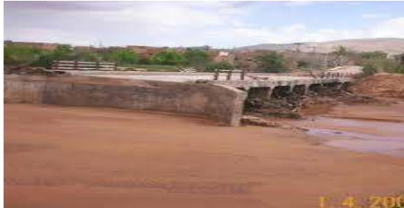
Figure I. 22: Affouillement des remblais d'accès d'un dalot en Algérie [3]
