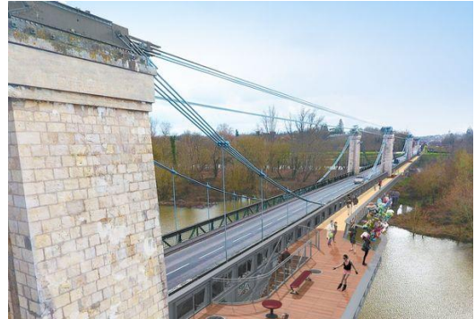
Figure 20:le Pont suspend de Châtillon-sur-Loire, source : le moniteur
