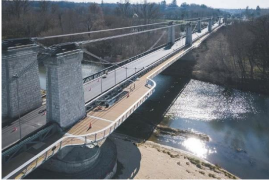
Figure 21:le Pont suspend de Châtillon-sur-Loire, source : franceinfo
