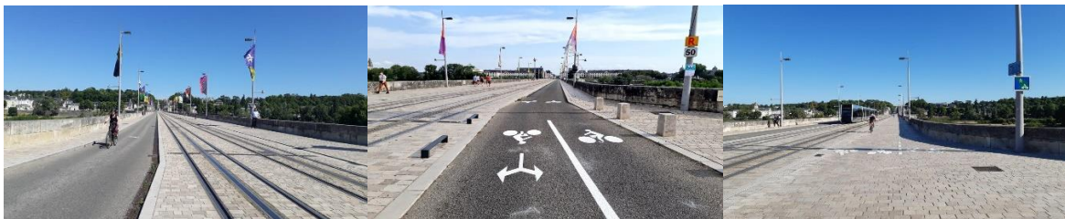
Figure 17:L'aménagement du pont Wilson à Tours, France source : rue de l'avenir
