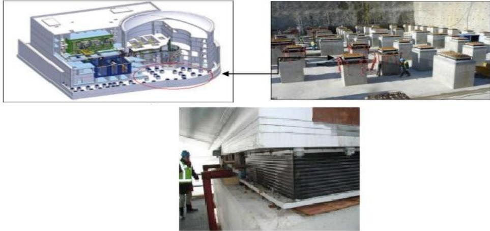
**Figure IX 13:** Schéma du réacteur expérimental Jules Horowitz (Cadarache, France) avec ses appuis parasismiques visibles dans la partie inférieure.
