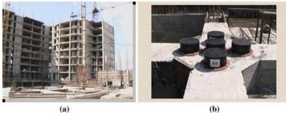
**Figure IX 18:** Bâtiment isolé à la base à Yerevan (Arménie).
