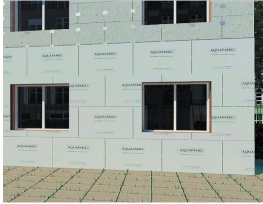
Figure I.8 : Mur extérieur (plaque en ciment)
