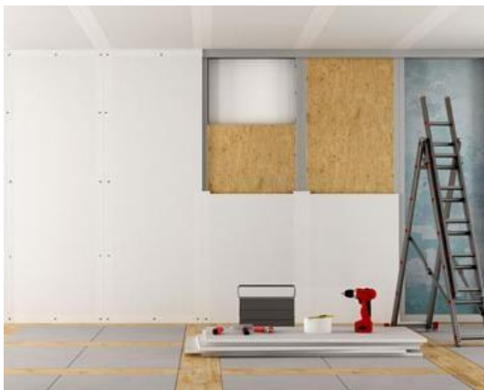
Figure I.7 : Mur en plaque au plâtre
