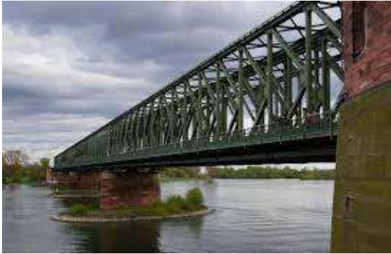
Figure I.12 Tablier de pont en treillis
