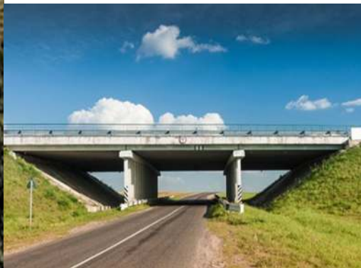
Figure I.2 Vue d'un pont routier
