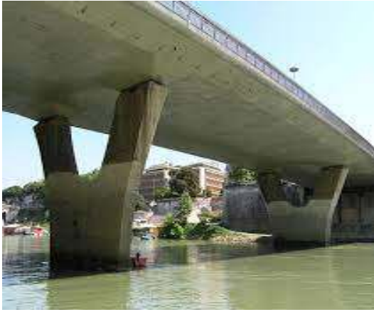
Figure I.6. Pont en béton précontraint
