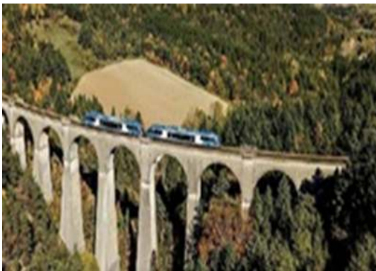
Figure I.1 Vue d'un pont rail
