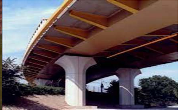
figure I.13 pont à tablier mixte
