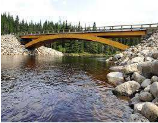
Figure I.8. Pont bois- précontraint
