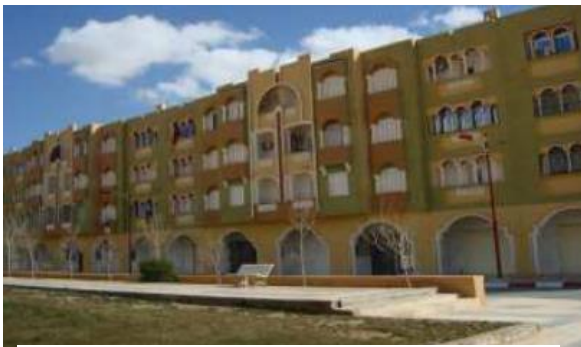
Figure 82 : Façade de rive Source : Ouldzemirli Mohamed, Mémoire, Apport de l'intégration des panneaux photovoltaïques au bilan énergétique d'une habitation bioclimatique, p87
