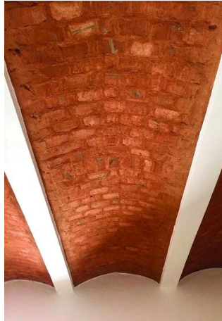
Figure 35: Voute en maçonnerie de terre , Source : BET united4design, Archdaily
