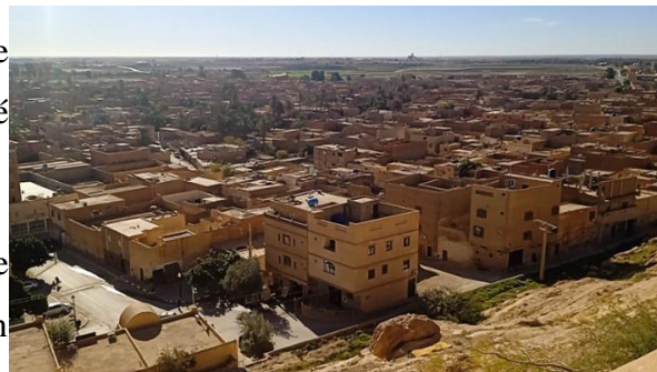
Figure 59 : Vue aérienne sur le ksar Source : Auteur
