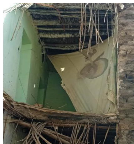
Figure 72 : Composition de toiture traditionnelle
