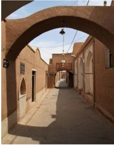
Figure 3 :Rue couverte en arc plein cintre Source :Olga, Au milieu du désert à Yazd, 05/2019
