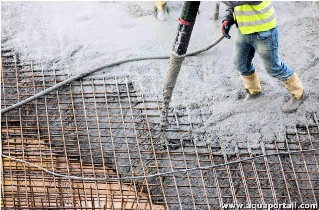
**Figure I. 3:** Exemple de coffrage en béton armé.
