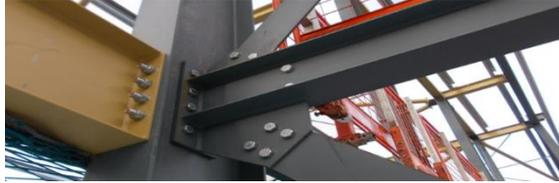
**Figure I. 6:** Assemblage boulonner.
