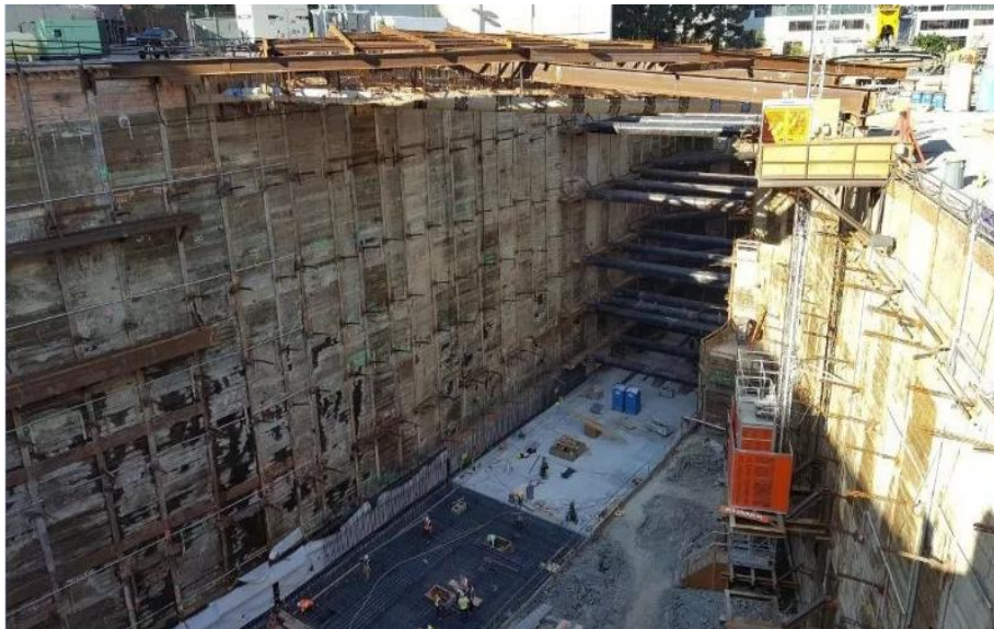
Figure I.4 : Excavation ancrée.
