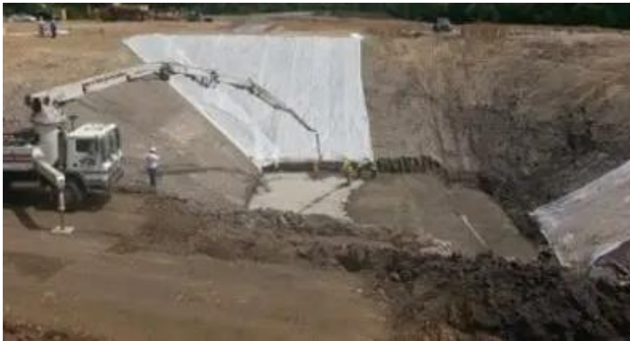
Figure I.1 : Excavation à ciel ouvert en pente.
