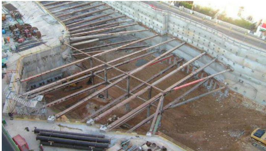
Figure I.11 : Exemple de butonnage.
