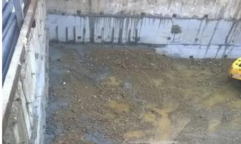
Figure I.2 : Excavation à ciel ouvert en porte-à-faux.
