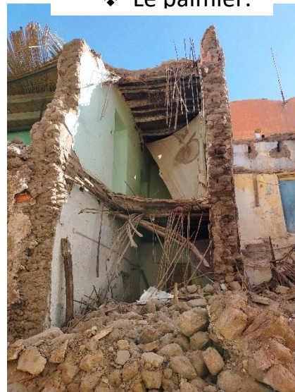
Figure 14 : planchers plats en troncs et branches de palmiers. Source : auteur.
