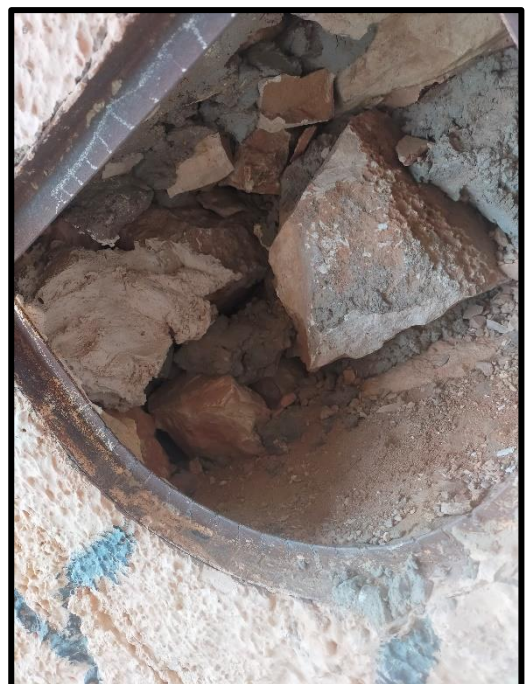
Figure 69 : mur en pierre lié au ciment à l'intérieur du Ksar Tafilalet. Source : auteur.
