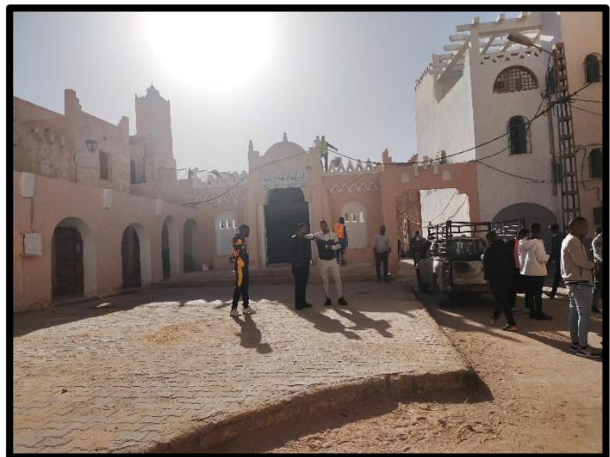
Figure 40 : travaux de réhabilitation. Source : auteur.
