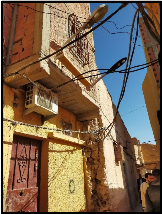
Figure 56 : maison dans le ksar avec des matériaux contemporaines. Source : auteur.
