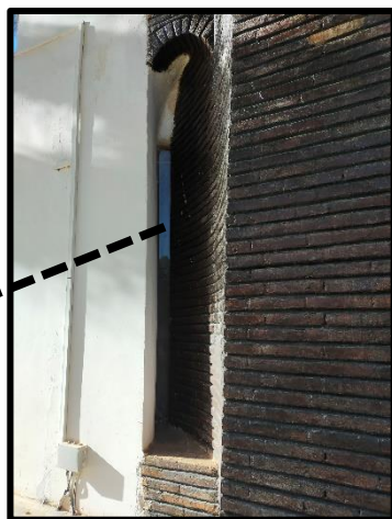
Figure 26 : ouverture pour l'éclairage de l'Hôtel Marhaba. Source : auteur.
