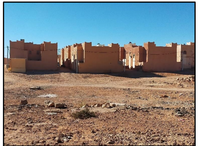
Vus sud « groupement d'habitation ».
