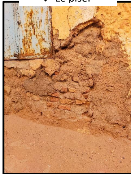
Figure 12 : Le pisé. Source : auteur.
