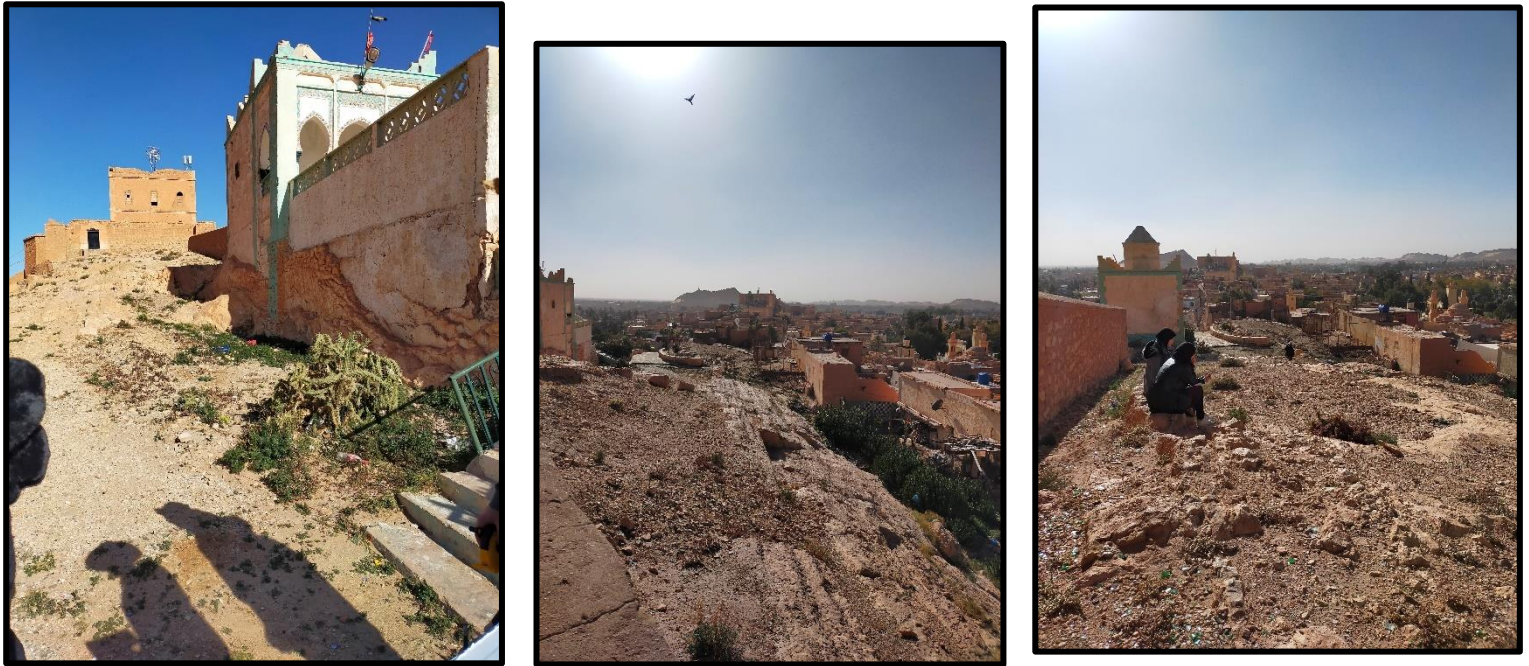
Figure 34 : le site d'intervention « le fort Morand ». Source : auteur.
