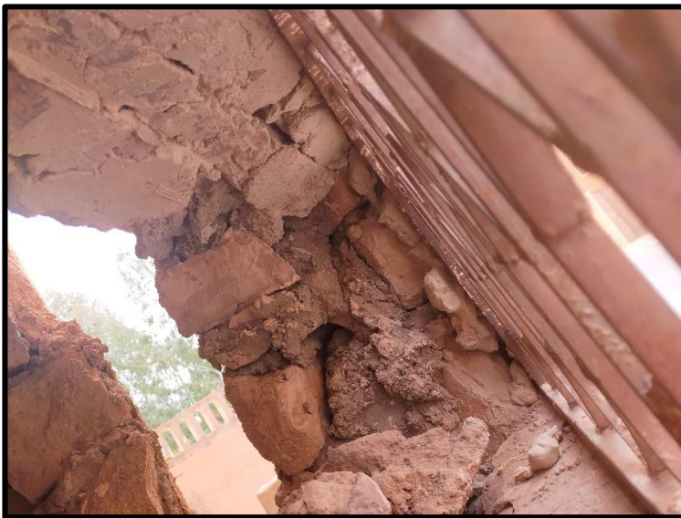
Figure 68 : mur en pierre et poutre en béton à l'intérieur du Ksar Tafilalet. Source : auteur.
