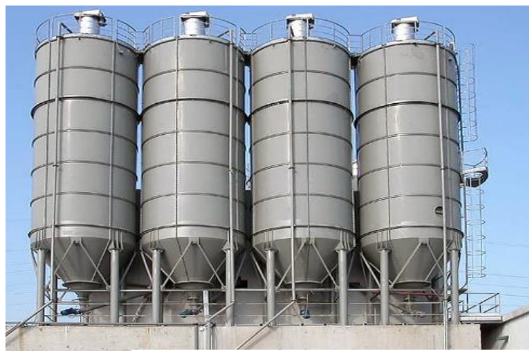
Figure I. 10 silo à ciment
