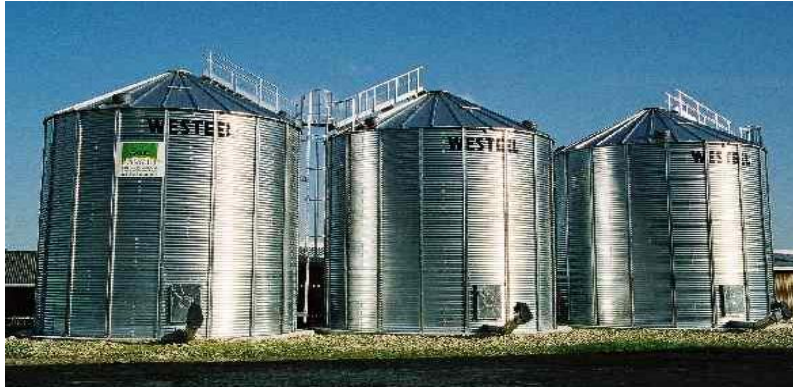
Figure I. 3 silo rond à fond plat
