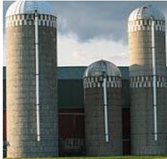
Figure I. 7 silo à double paroi
