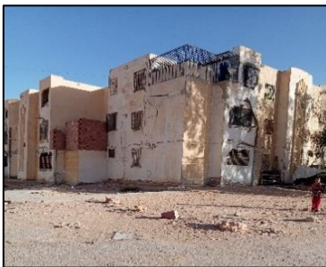
Figure 102 : habitats collectifs Source : auteurs 2023
