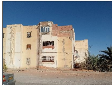
Figure 103 : habitats collectifs Source : auteurs 2023
