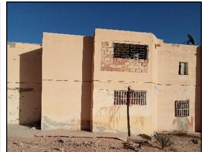
Figure 104: habitats semi-collectifs Source : auteurs 2023
