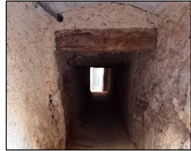
Figure 25 : construction avec tronc de palmier a ksar Ouargla Source : auteurs 2023
