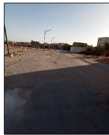
Figure 95 : voie tertiaire Source : auteurs 2023
