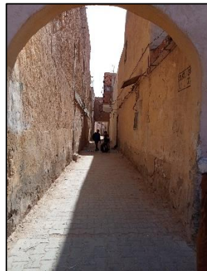
Figure 12 : voie principale à ksar Ouargla Source : auteur 2023
