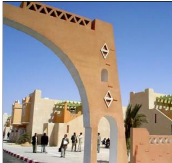
Figure 64 : la porte urbaine Source : Vies des villes, Projet des 100 Logements AADL, à Touggourt
