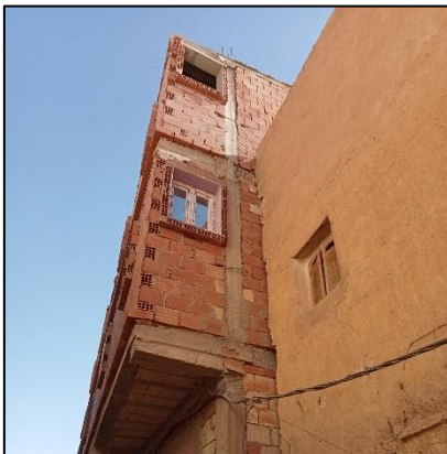
Figure 73 : habitation réhabilité au ksar Source : auteurs 2023
