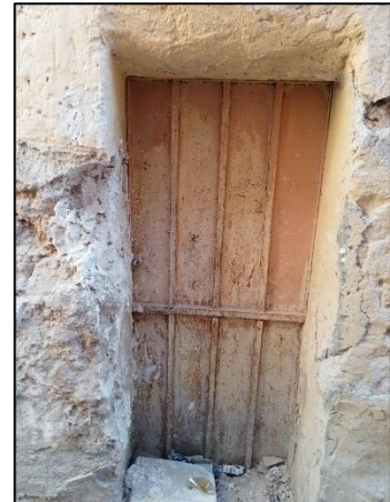
Figure 72 : porte d'une maison traditionnelle Source : auteurs 2023
