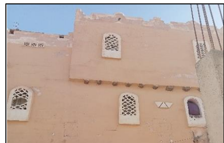
Figure 54 : façade d'une maison traditionnelle Source : auteurs 2023
