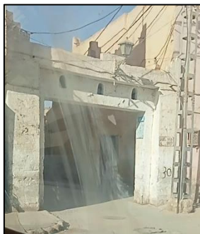
Figure 6 : Bâb sultane Source : auteurs 2023
