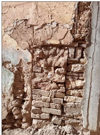
Figure: construction en pierre Source: auteurs
