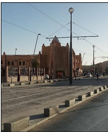
Figure 93 : voie principale Source : auteurs 2023
