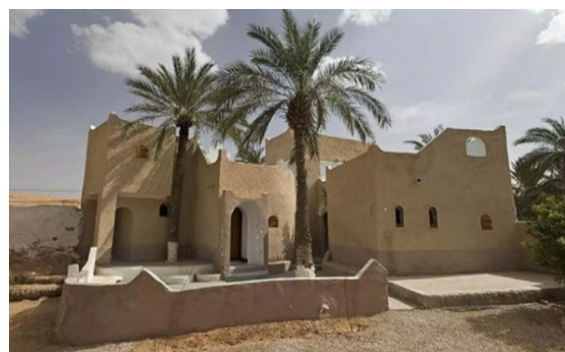
Figure 94 : Maison de palmeraie de M'Zab
