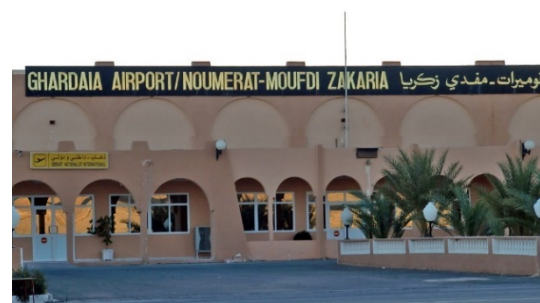
Figure 41 : Image de l'aéroport de Ghardaïa
