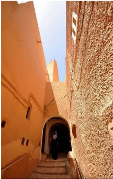
Figure 81 : Image des façades à Ghardaïa
