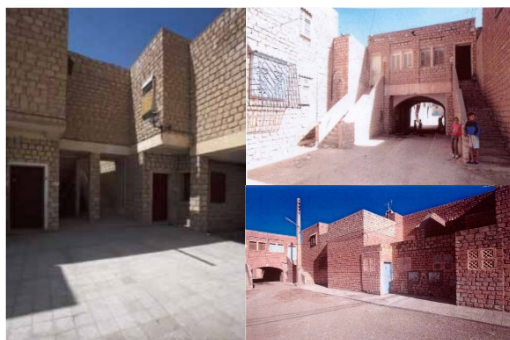
Figure 34 : Quelques façades du projet
