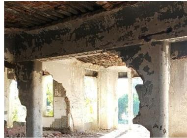
*Figure 96:le système poteau-poutre du château*
