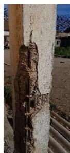
*Figure 109: Corrosion du béton*
