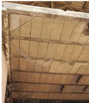
*Figure 93:La dalle en corps creux du bloc de vinification*
