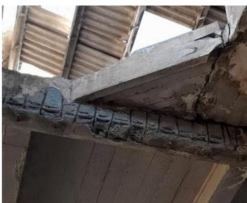
*Figure 110: plancher Dégradé, effondrement de la couche du plâtre*
