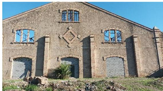
*Figure 106: Fermeture des ouvertures avec de la brique*
