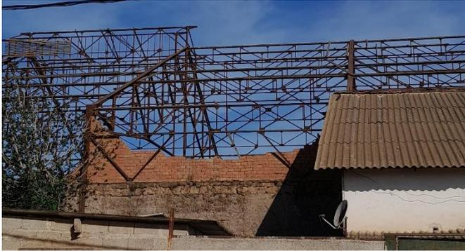
*Figure 91:La charpente métallique*
