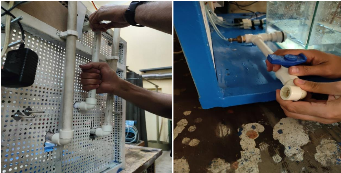
Figure 4.25 : réalisation du circuit hydraulique
