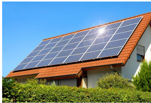
Figure 1.16 : Les panneaux solaires
