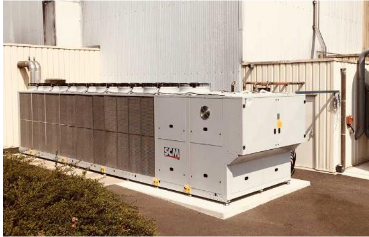
Figure I.3 : Système de Refroidissement dans une usine
