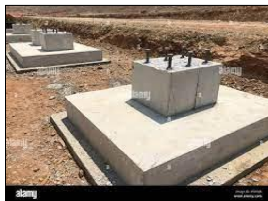
Figure 59 : semelle isolée Source : https://www.alamyimages.fr/rangee-de-fondations-en-beton-arme-avec-des-boulons-d-ancrage-metallique-
