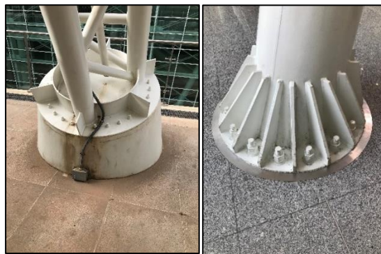
Figure 58 : jonction infrastructure/superstructure Source : https://structurae.net/fr/ouvrages/frick-chemistry-lab
