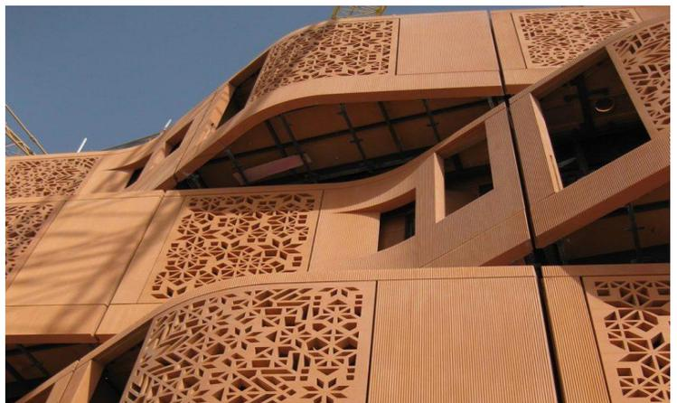
Le BRV béton renforcé vitrifié il a été créé par des experts ; un matériau unique composé de béton et de verre. Le bois utilisé dans toute la ville est celui de palmier. La peau des murs du laboratoire les protégeait du soleil direct. La température interne a été évitée en utilisant des coussins ETFE gonflables à haute isolation.
