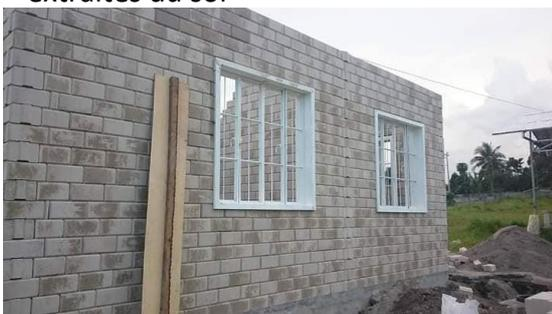
**Figure215 :** brique de terre stabilisée.
