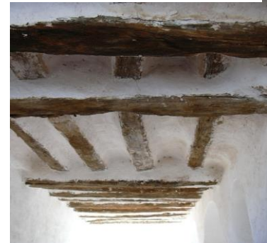
Figure 55: utilisation du palmier dans le toit
