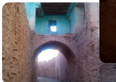
Figure 70: Chambre pont SOURCE: trouver par l'auteur
