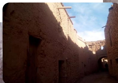
Figure 70: Chambre pont SOURCE: trouver par l'auteur
