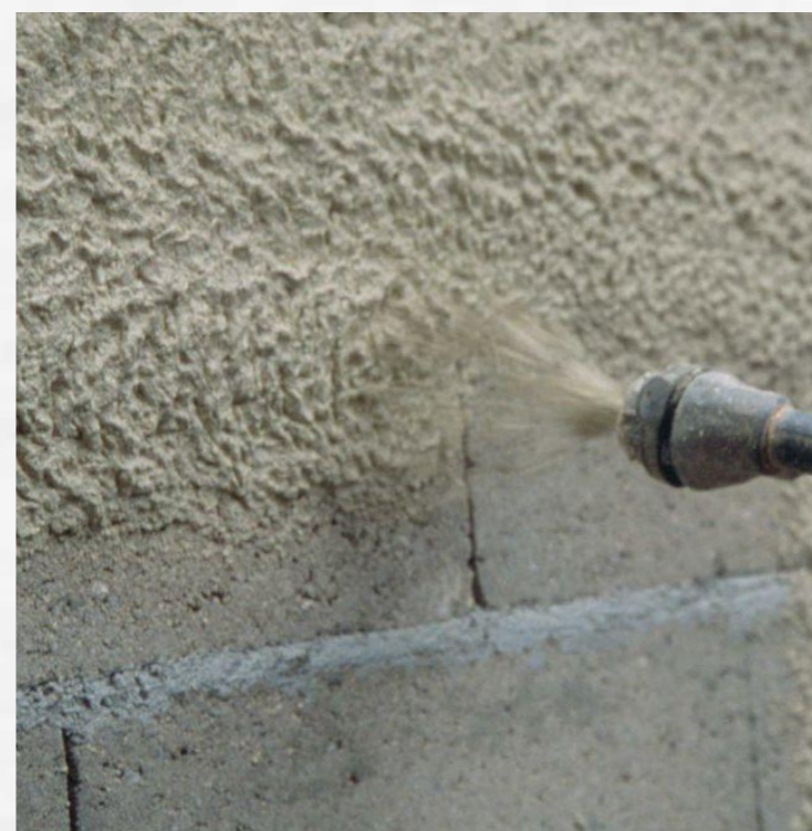
Figure 7: Enduit à base de chaux https://www.archiexpo.fr/prod/lafarge-concrete/product-67208-2022051.html
