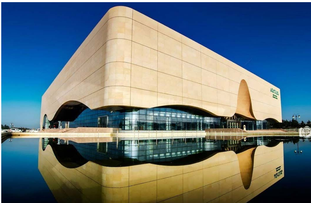
Figures 116 : Vue sur l'opéra d'Alger
