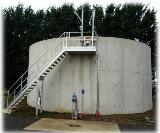
figure 9 : silo à boue sur la station d'épuration
