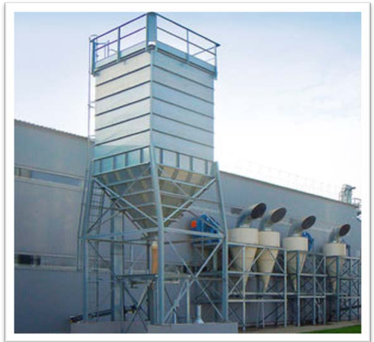
Figure13 : Silos carrés à fons coniques
