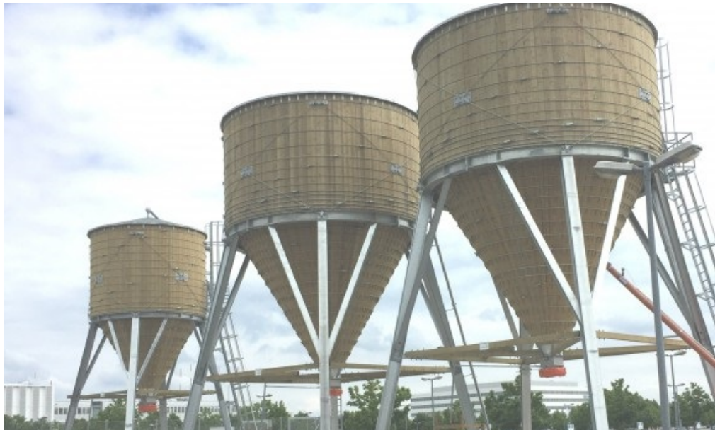
Figure02 : Des silos en bois pour le stockage du sel.
