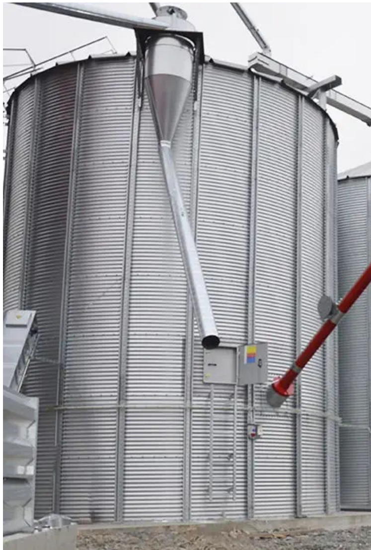
Figure12 : Silo cylindre tôle ondulée en d'acier
