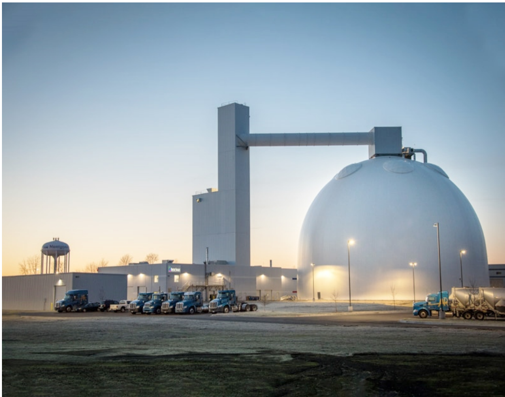
Figure 16 : Silo dôme de sucre blanc de 60 000 t à American (Crystal Sugar).
