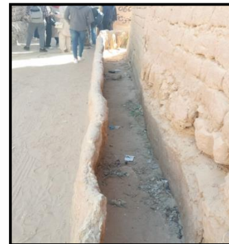
Figure 218: segua de distribution d'eau. Source : l'auteur durant la visite de site
