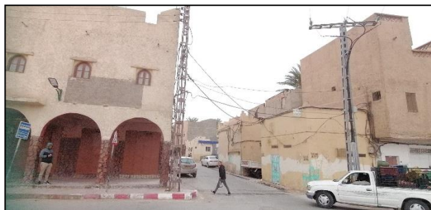
Figure 224: photo des façades dégradé du boulevard. Source : prise par l'auteur
