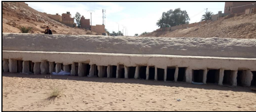
Figure 216: les canaux de récupération et drainage d'eau. Source : auteur durant la visite du site
