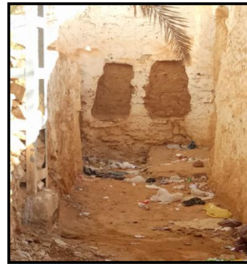
Figure 217: les ouvertures aux pieds des murs de clôture. Source : auteur durant la visite du site
