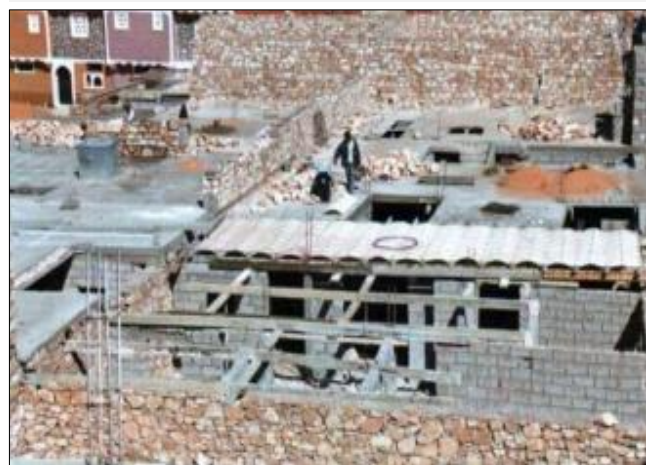
Figure 169: photo de chantier de ksar tafilalet. Source: fondation amidoule.
