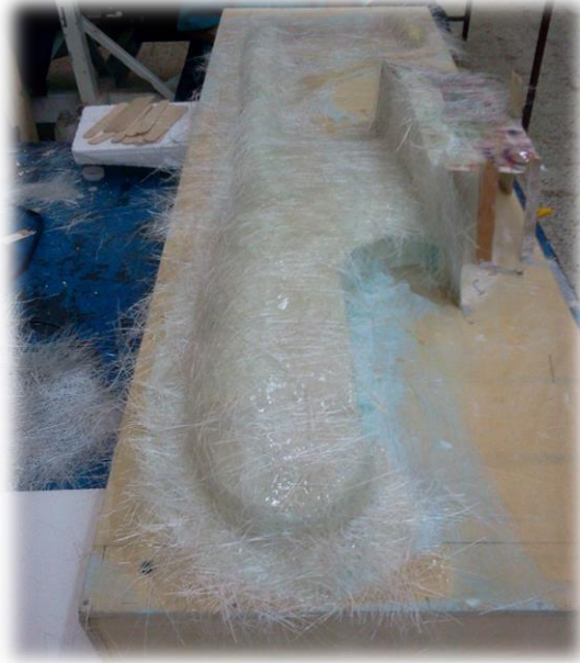
Figure (IV-31). Application de la première couche de résine.
