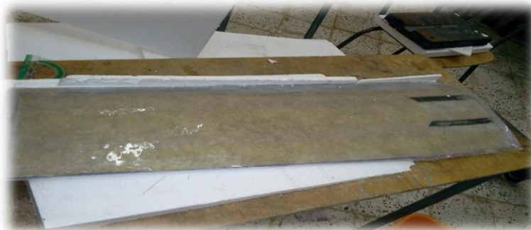
Figure (IV-22). Revêtement des ailes par le composite.
