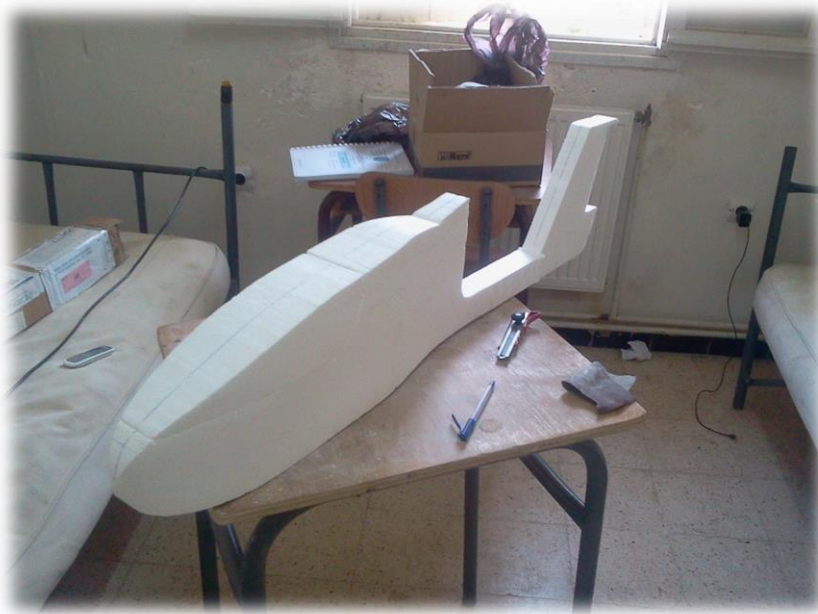
Figure (IV-4). Découpage de dessus du fuselage.
