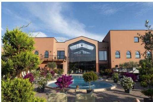
Figure 38 façade principale du projet /Pinterest
