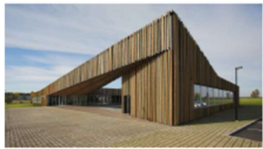
Figure 46: la façade latérale gauche
