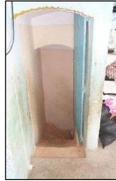
Figure 155: photo de l'escalier par l'auteur
