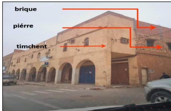
Figure 202: photo des matériaux sur la façade. Source : prise par l'auteur
