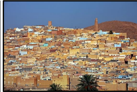
Figure 66: ksar Ghardaïa. Source : OPVM
