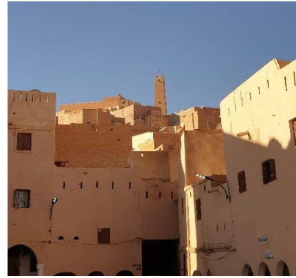
Figure 3: photo de ksar de l'atteuf. Source : prise par l'auteur
