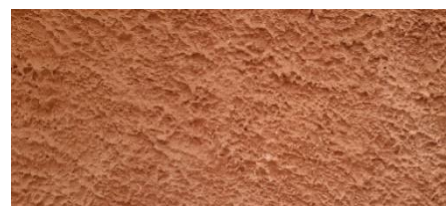
Figure 168: photo de timchemt. Source: l'auteur durant la visite du site
