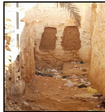
Figure 188: les ouvertures aux pieds des murs de clôture. Source : auteur durant la visite du site
