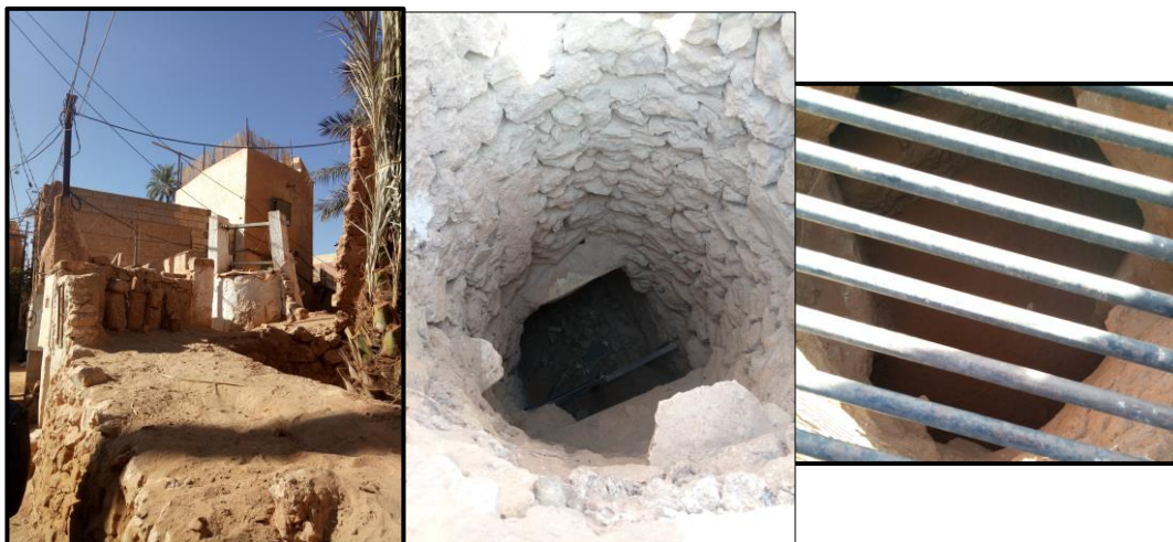
Figure 186: les puits d'irrigation de la palmeraie. Source : auteur durant la visite du site
