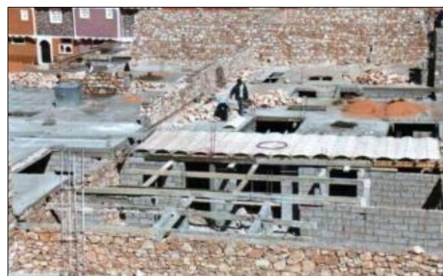
Figure 140: photo de chantier de ksar tafilalet. Source: fondation amidoule.
