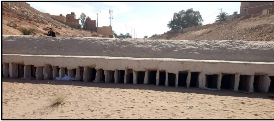
Figure 187: les canaux de récupération et drainage d'eau. Source : auteur durant la visite du site
