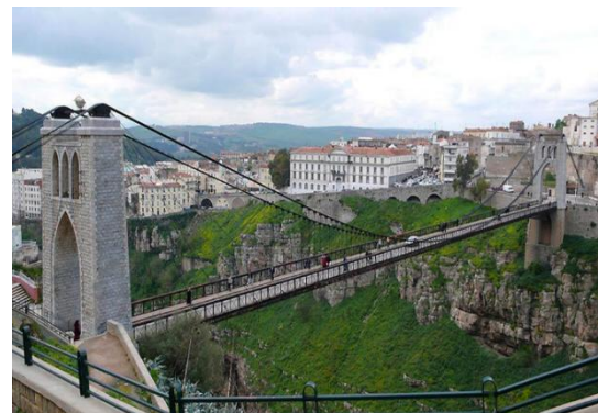
Figure II-35: câbles de retenue, source : https://www.easyvoyage.com/photos/algerie/12233-constantine-1625 consulté le 30/01/2018
