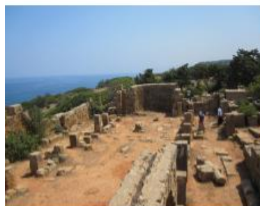
Absence de parcours piétonne
