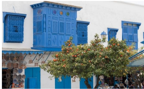
Figure II-25 : utilisation du béton et du moucharabieh en bois, Sidi Bou Saïd, Tunisie, Source Google Image consulté le 23/01/2018
