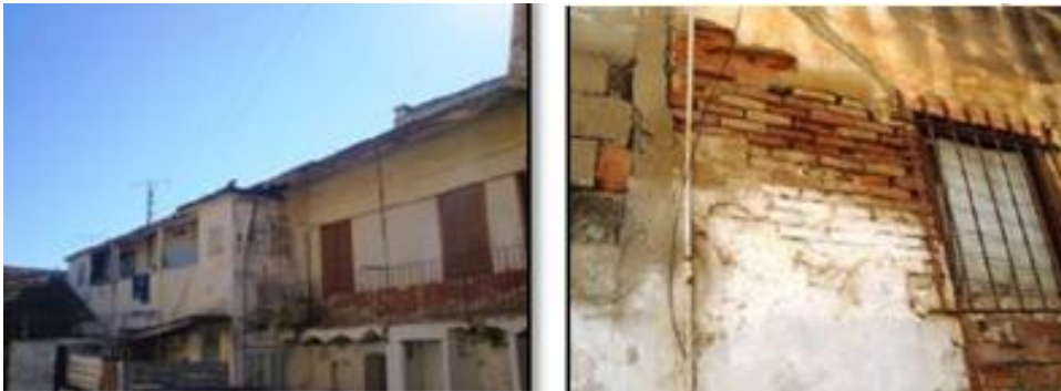
Figure IV-12: matériaux de construction dans le tissu colonial Source : Mémoire Master AZIT - Aménagement des
