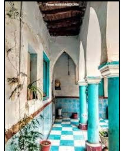
Photo 42 : La galerie de la maison Bouameur source http://sidielhadjaissa.over-blog.com/2016/08/les-travaux-de-restauration-de-la-maison-bouameur-ont-commence.html décembre 2018
