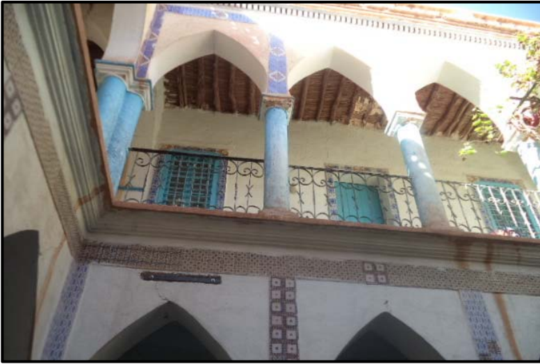
Photo 41 : La maison Bouameur source http://sidielhadjaissa.over-blog.com/2016/08/les-travaux-de-restauration-de-la-maison-bouameur-ont-commence.html décembre 2018
