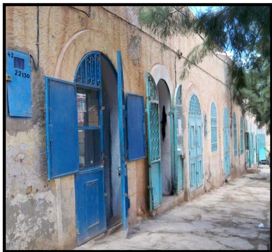
Photo 69 : vue 04 façade nord-ouest du 1er bloc source auteur
