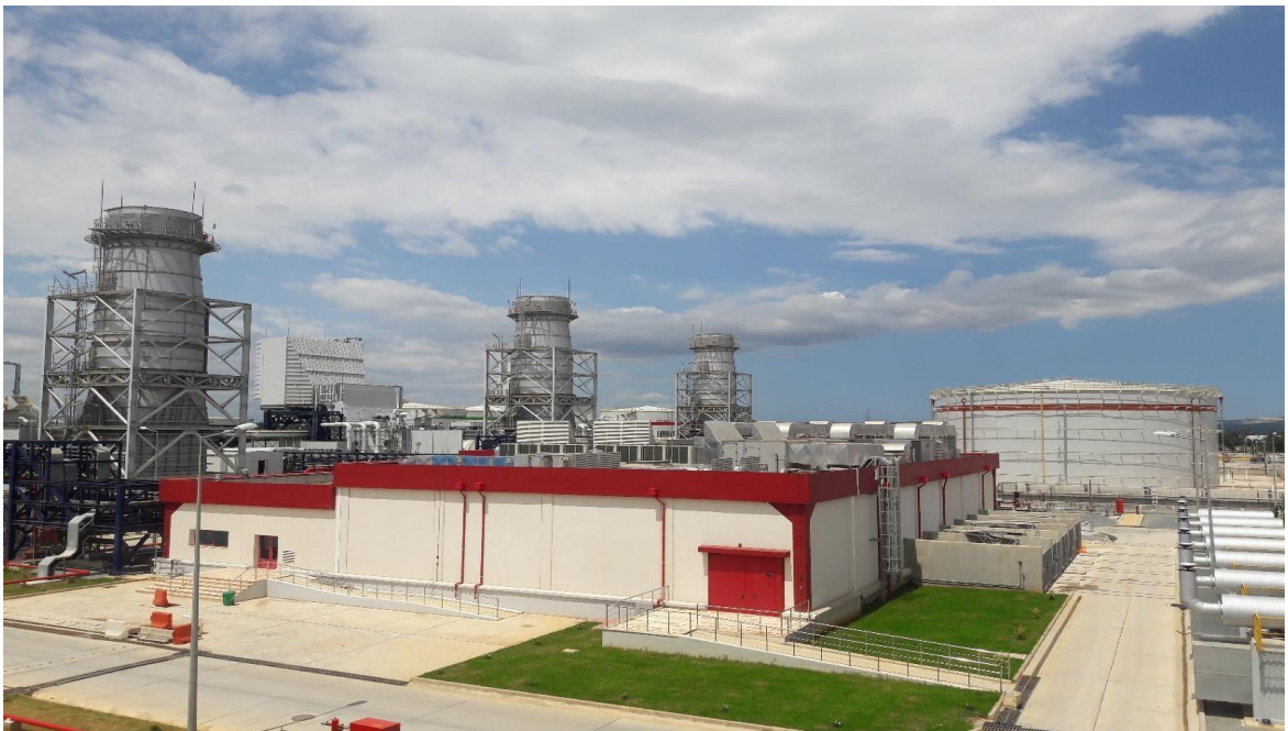
Figure. II. 1 : vue dessus de la Centrale électrique.
