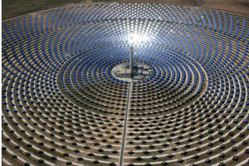
Figure (I-12) : Les héliostats d’une centrale solaire thermique
