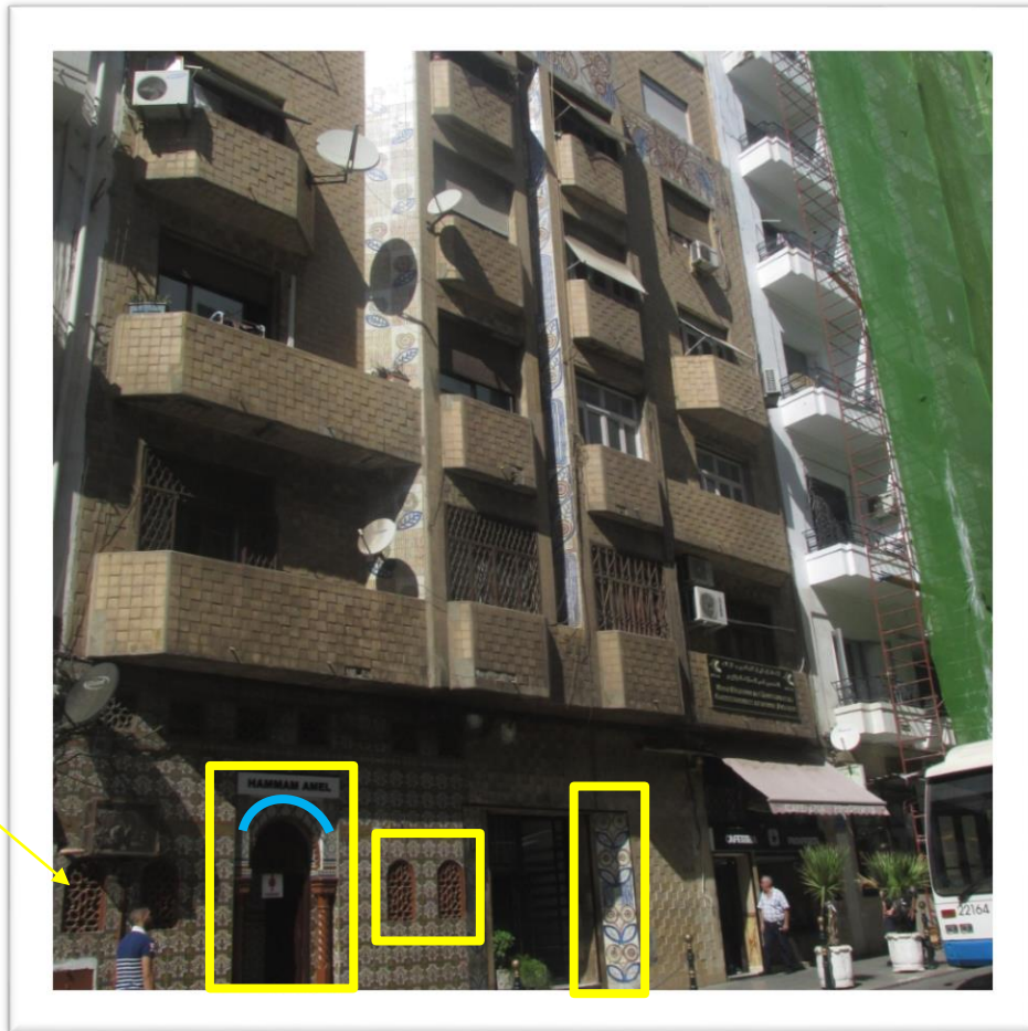
Façade montrant l'entrée du magnifique immeuble avec une touche arabesque. (Mosaïque, arcs et Moucharabieh)
