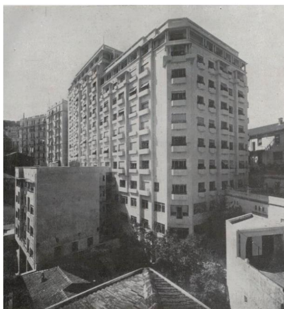
Chantier fini. (même perspective que la photos précédente)
