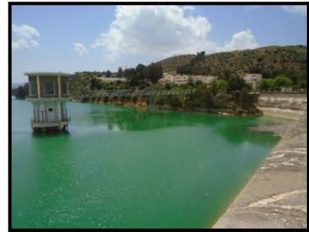
Fig. 47 : Barrage Ghrib le mois d'Avril
