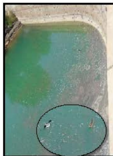
Fig. 40 : La digue du Barrage Ghrib
