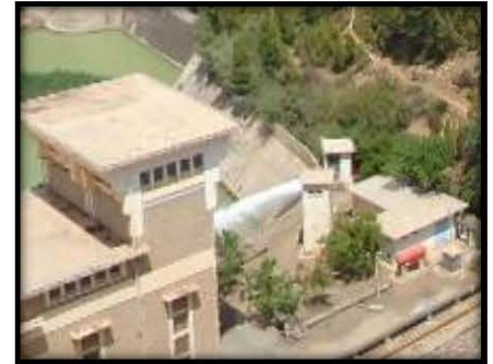
Fig. 06 : vanne pour l'irrigation Barrage (photo original)
