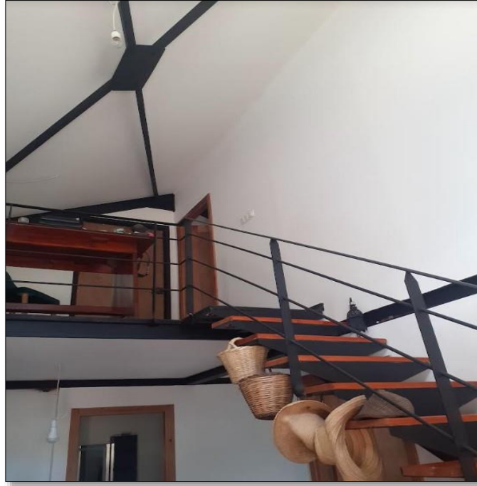
Figure 1.9: maison à ossature métallique en acier source auteur le 10/01/2023
