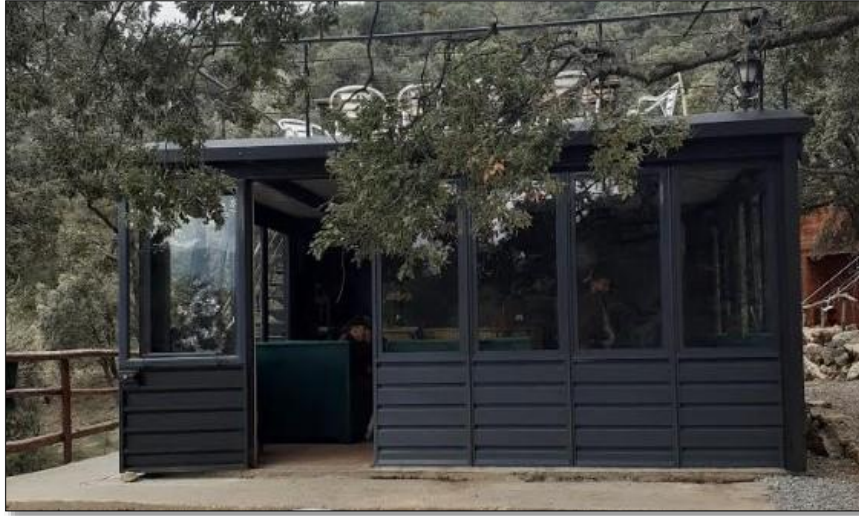
Figure 1.10 : Restaurant métallique à bardage simple peau source auteur le 19/03/2023
